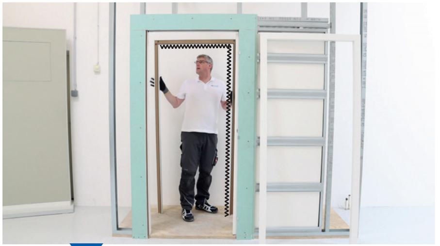
Erste Seite befestigen und oben Abstand zu Schienenträgerprofil (5 cm) prüfen.
